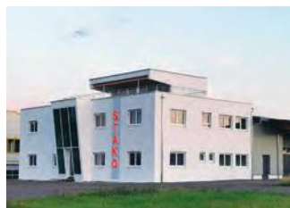
Neubau der STAKO-Gruppe in Wolpertshausen. Foto: Stako
