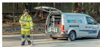
Johannes Ehleiter bei der Störungssuche im Wassernetz der Stadtwerke Schwäbisch Hall. Foto: Stadtwerke
