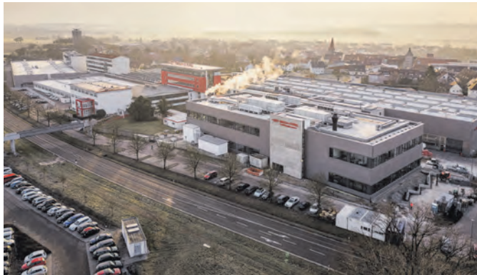
Bausch + Ströbel Headquarter in Ilshofen. Foto: Bausch+Ströbel
