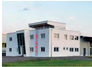
Neubau der STAKO-Gruppe in Wolpertshausen. Foto: Stako
