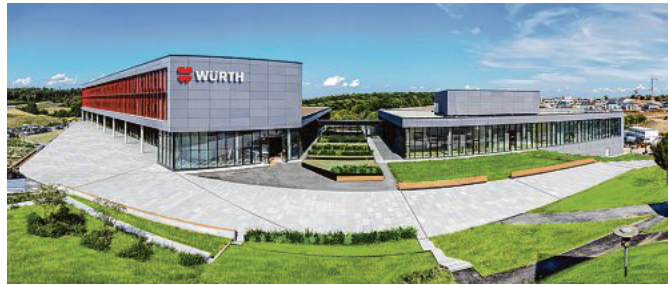
Neues Innovationszentrum am Standort Künzelsau. Mehr Informationen unter wuerth.rocks/innovationszentrum . Foto: Würth
